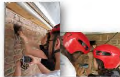
Ispezione delle buche pontaiate tramite endoscopio.
