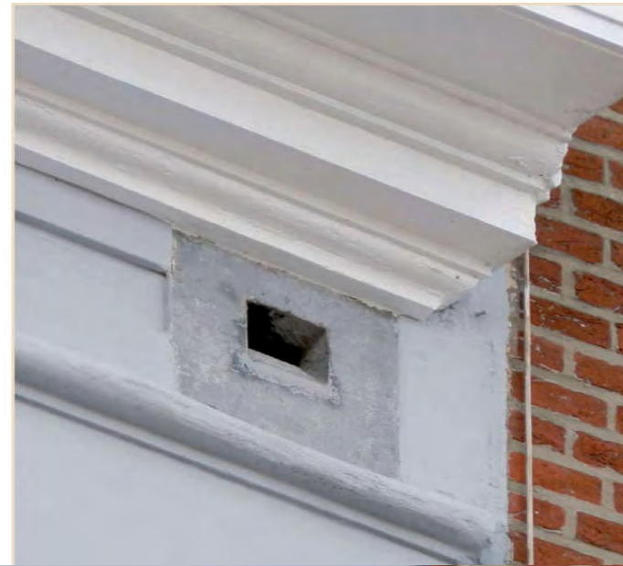
Photo 11 – Aménagement de trou de boulin « à l'italienne » / An Italian style scaffolding hole (© M. Wauters)
