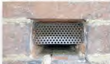
Buca pontaiata parzialmente ostruita per permettere la nidificazione dei rondoni (in alto) ed escludere i colombi.
